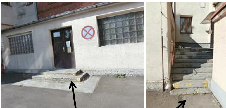
Vstup do tělocvičny, zadní vstup do objektu
