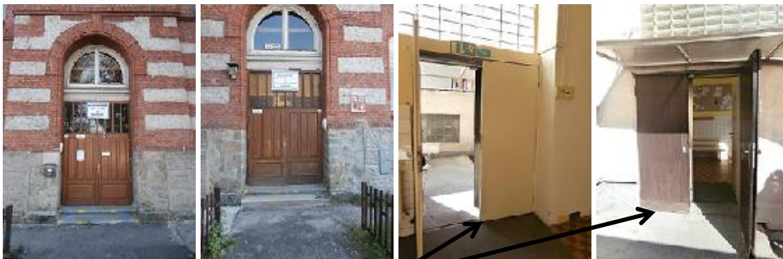
Hlavní vstupy do objektu školy, zadní vstup
