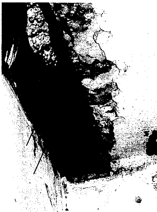
Kotevní prvky obvodového pláště při pohledu do styčné spáry zdola
