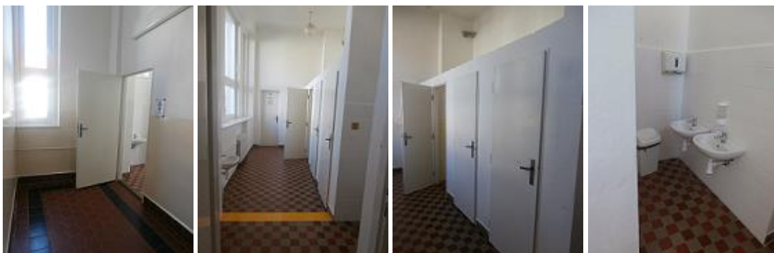
Stávající sociální zařízení ve 3.NP – situována ve východní části objektu
