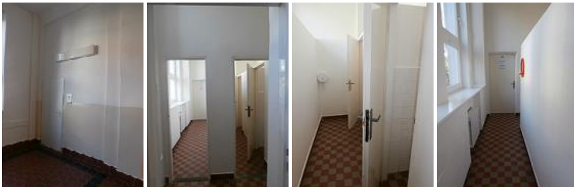
Stávající sociální zařízení ve 2.NP – situována ve východní části objektu
