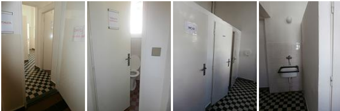
Stávající sociální zařízení v západní části objektu (1. – 3. NP jsou stejná)
