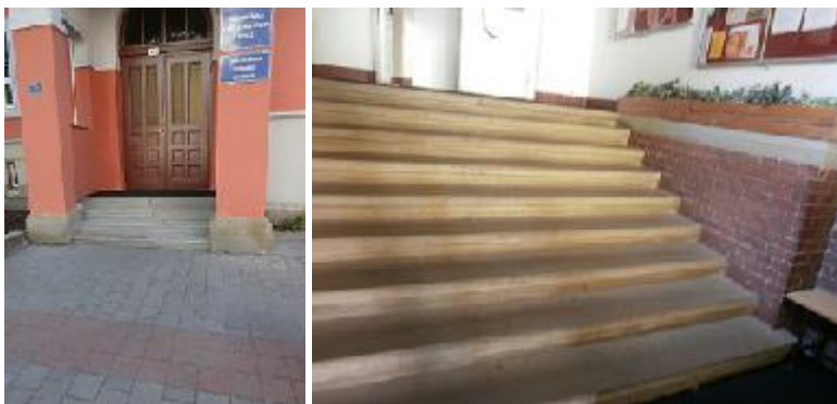
Vstupní venkovní a vnitřní schodiště
