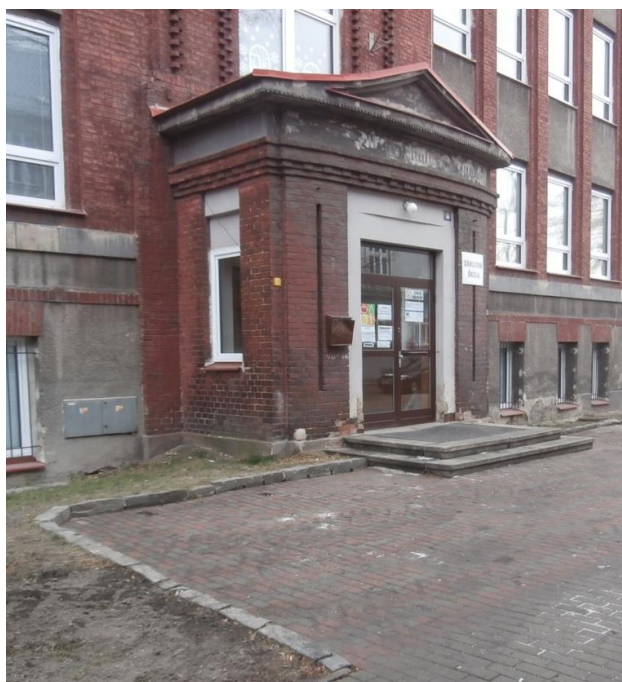
Foto č. 3 – hlavní vstup: Zrušení schodiškových stupňů
