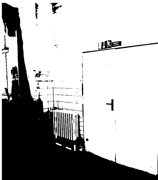
Foto č. 4 – dveře na dvůr: Posunutí a vytvoření výstupu z výtahu
