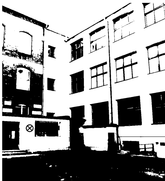
Foto č. 3 – dvorní fasáda: Umístění výtahu
