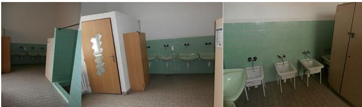
Prostor pro vybudování sociálního zařízení v objektu s tělocvičnou
